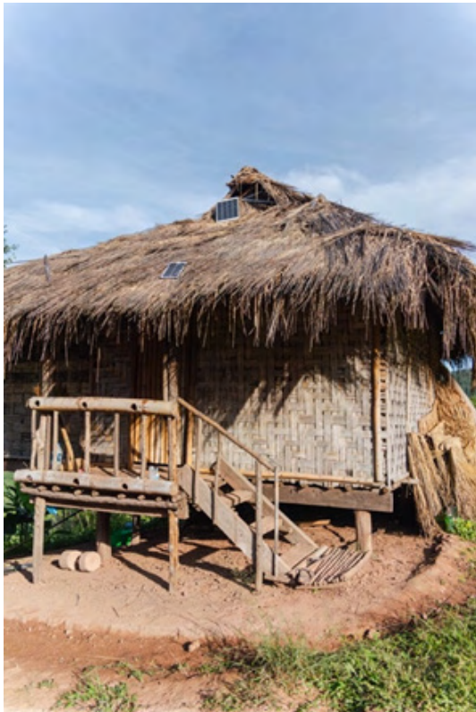
ภาพที่ 6 หลังคาเซลล์สุริยะ Solar Cell Roof ที่มา: ผู้เขียน (บัณฑิต สัตย์เพริศพราย, 2567)
